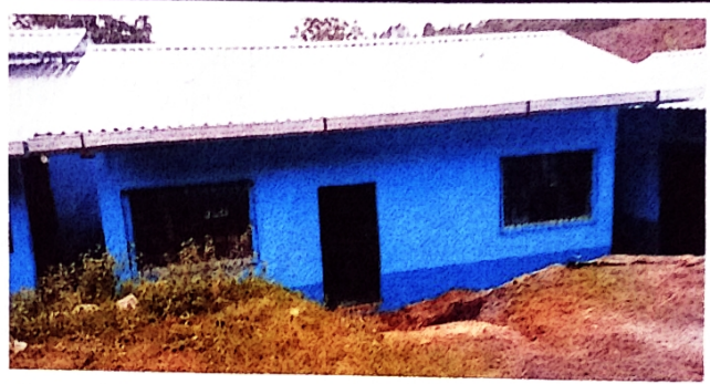
Foto 2: el techo del aula 2 ya se encuentra completamente modificado con láminas y costaneras nuevas.
