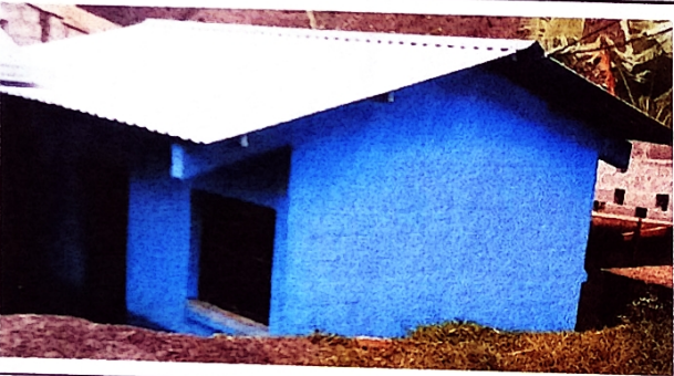
Foto 3: el techo de la bodega ya se encuentra completamente modificado con láminas y costaneras nuevas.
