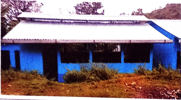
Foto 1: el techo del aula 1 ya se encuentra completamente modificado con láminas y costaneras nuevas.
